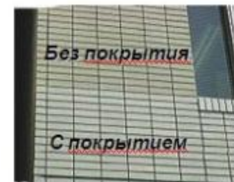
Наружная очистка воздуха
